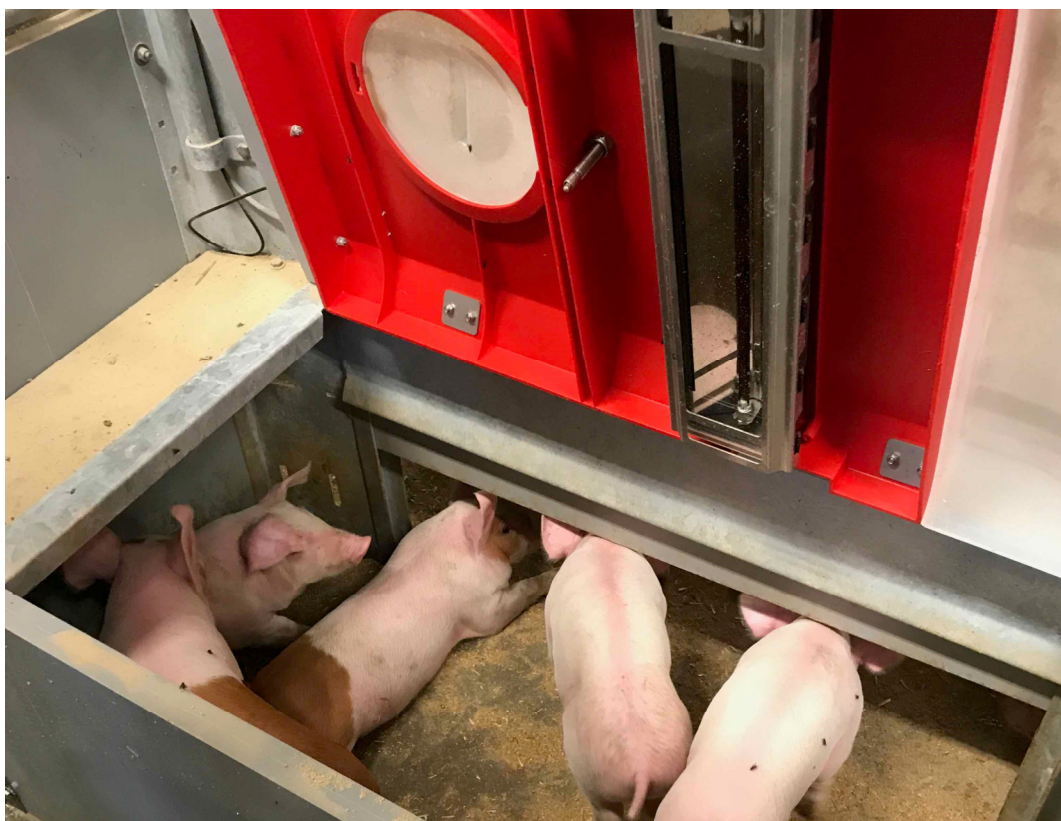
Figur 9. Smågrishörna med termostatstyrt värmetak. Foto RISE Jordbruk och trädgård.
