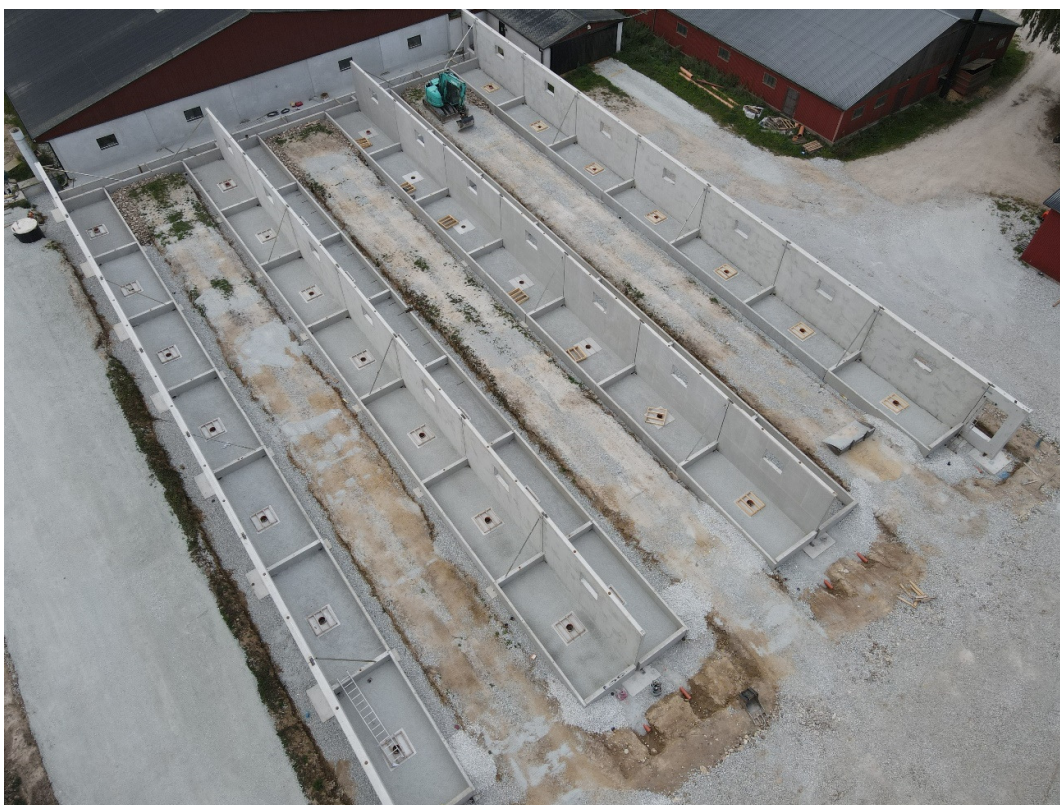
Figur 1. Byggnation av ett slaktgristall på Gotland år 2021. Foto Olof Ahlby.
