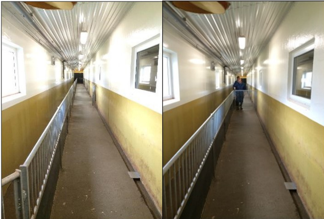
Figur 6. Utlastningskorridor med persongång samt gång för drivning av grisar. Grindar finns monterade längs vägg och som delar upp gången i olika fack med möjlighet till begränsat antal grisar per fack. Grindarna hindrar även grisarna från att backa. Ventilation är separerad från avdelningarnas ventilation. Avloppsränna finns för avledning av spillvatten efter tvätt. Foto Gård och Djurhälsan.
