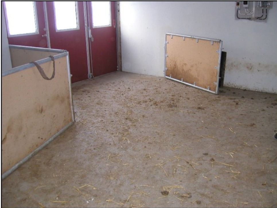
Figur 7. Utlastningsrum. Lastbilens läm ska kunna ansluta väl till utlastningens golv eller platta. En bredd på 2000–2500 mm samt en sockelhöjd på 450-500 mm rekommenderas. Då många transporter numera har luftfjädring är sockelhöjden lite mer flexibel (rådfråga transportören). Det är en fördel om djuren kan gå i svag lutning upp på bilen. Foto Gård och Djurhälsan.
