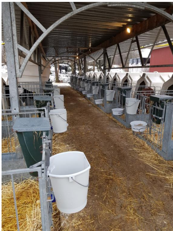
Bild 5: Kalvstall för mjölkdrickande kalvar i ensamhyddor. Tak över mittgången där utfodringen sker samt över ströytan. Håller foder och strö torrt samt uppskattat av kalvskötaren som slipper gå ute i alla väder. Uppskattat både vid blöta och varma dagar.
